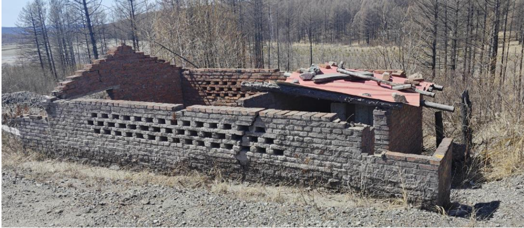
照片 4-6 废弃建筑拆除前
