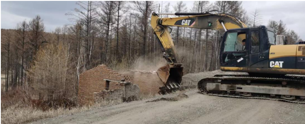
照片 4-7 废弃建筑拆除中
