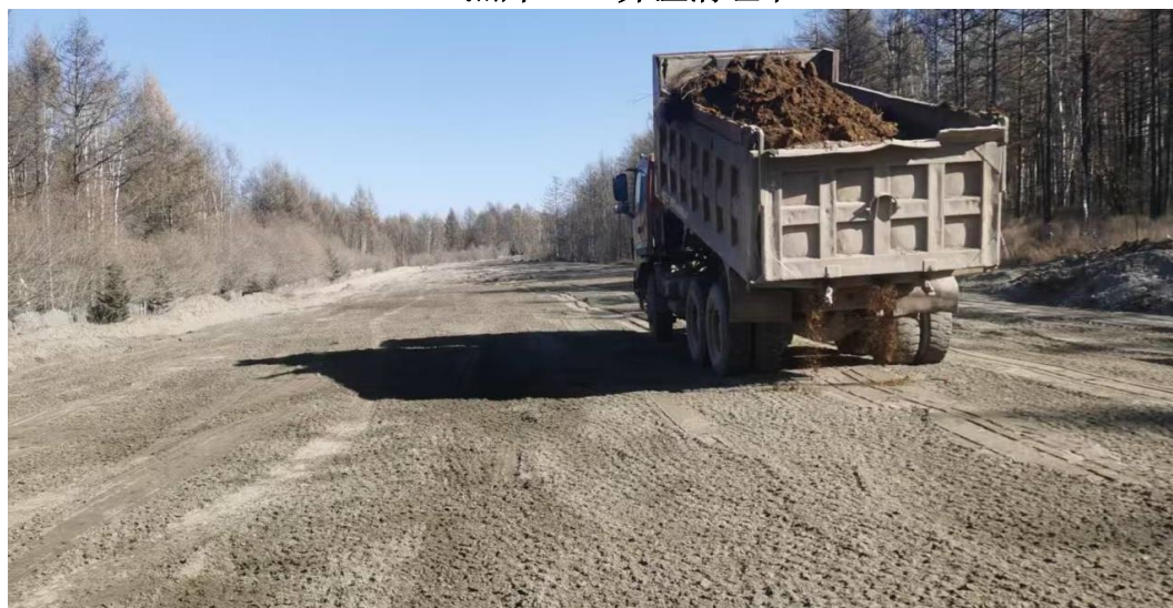
照片 4-5 弃渣清理后场地覆土
