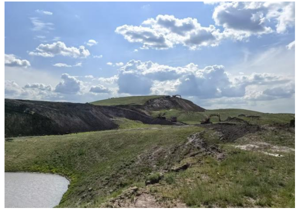
排土场边坡治理
