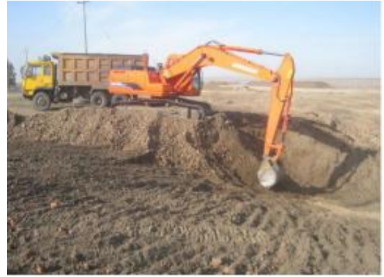
图 4-2 治理过程中表土剥离
