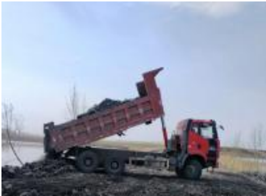
图 4-3 治理过程中矸石回填图
